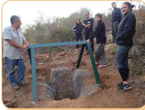
antirouille vert-maquis. Les quatre pieds sont boulonnés sur place, un peu de terrassement permet de positionner le portique à la verticale du trou. Il restera l'aménagement des abords à faire, de grosses pierres plates cerneront l'entrée et seront « clouées » en place avec des fers à béton.
