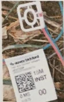
Le raccordement dans une même volée de détonateurs Nonel se fait par l'intermédiaire de blocs de raccordement spéciaux (fig. 16).
